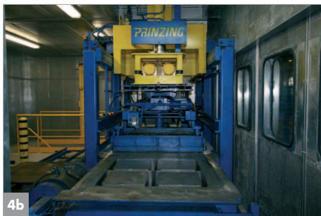
Caisson d'insonorisation avec portes automatiques
