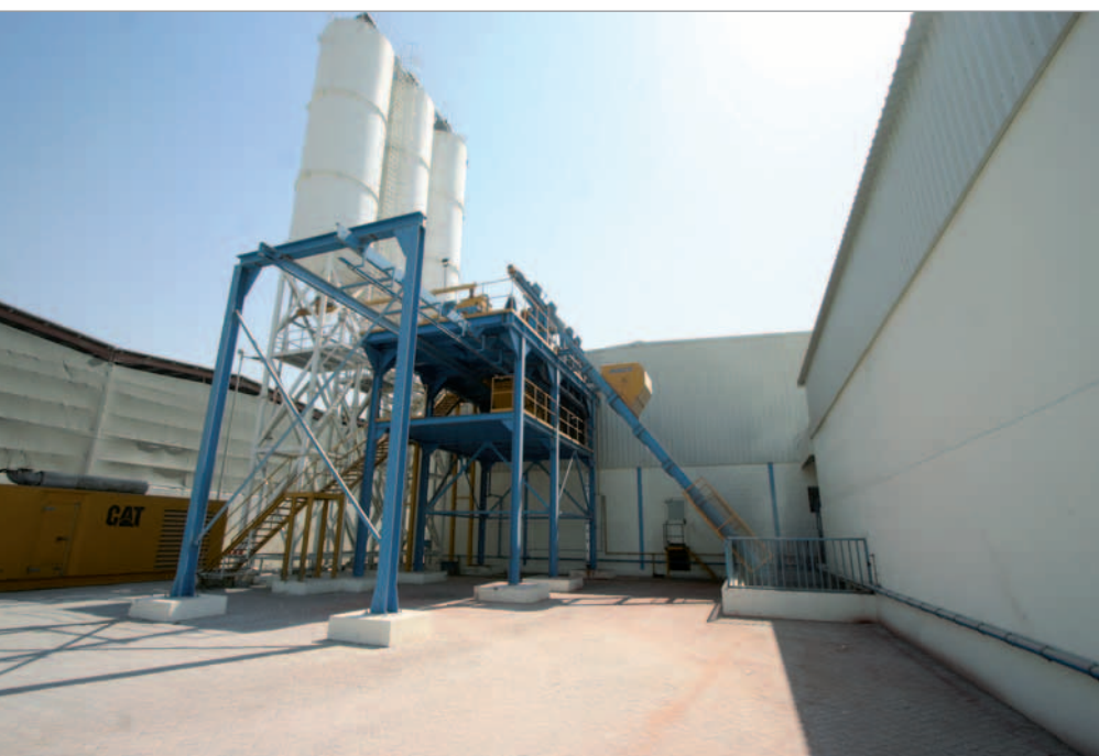
Bei den Wetterverhältnissen in Dubai ist ein Gebäude für die Mischanlage nicht erforderlich
