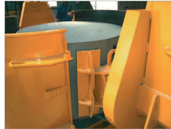
Démoulage du fond de regard terminé. Jean-Claude Pitois: „Perfect respecte l’identité du béton, on reste dans le même métier, notre métier.”
