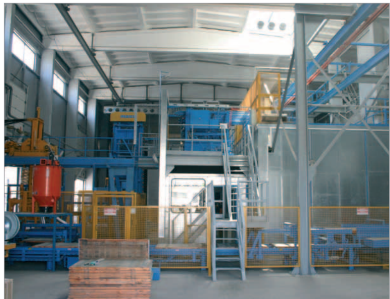
Aus Schallschutzgründen ist die Steinformmaschine Record 9001 VB komplett isoliert.
