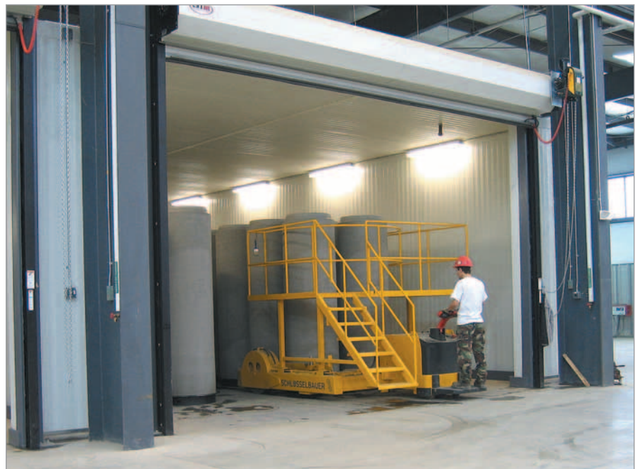
Aushärtekammern für optimale Erhärtung der Rohre
